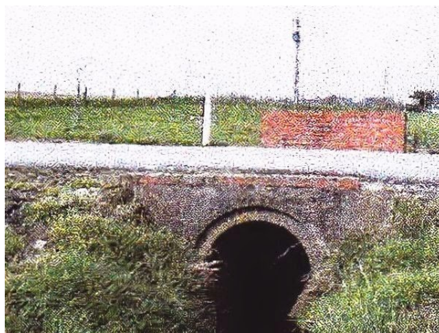
Figure 35 : Le ruisseau du Graty coule sous le pont routier du chemin d'accès à la ferme du Grati (diamètre d'environ un mètre).
