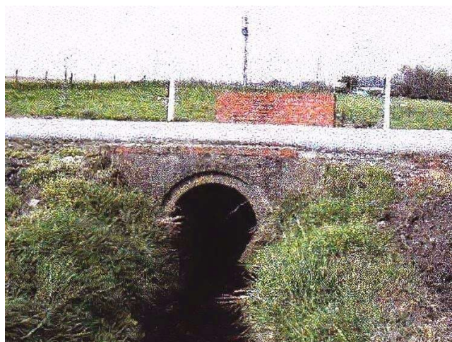
Figure 41 : Le ruisseau du Graty coule sous le pont routier du chemin d'accès à la ferme du Grati (diamètre d'environ un mètre).
