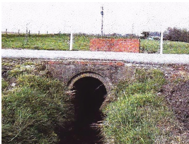
Figure 34 : Le ruisseau du Graty coule sous le pont routier du chemin d'accès à la ferme du Grati (diamètre de +1- un mètre).
